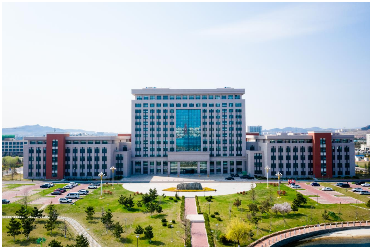
拍摄地点：威海职业学院 拍摄时间：2021年7月 拍摄者：王跃飞
